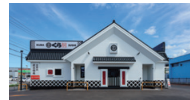
■ くら寿司 札幌八軒店 札幌市西区八軒6条西10-3-5
