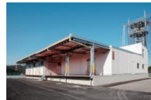
福岡センター外観
